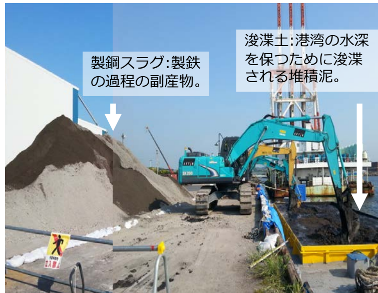
2. 浚渫土と製鋼スラグの現場混合
